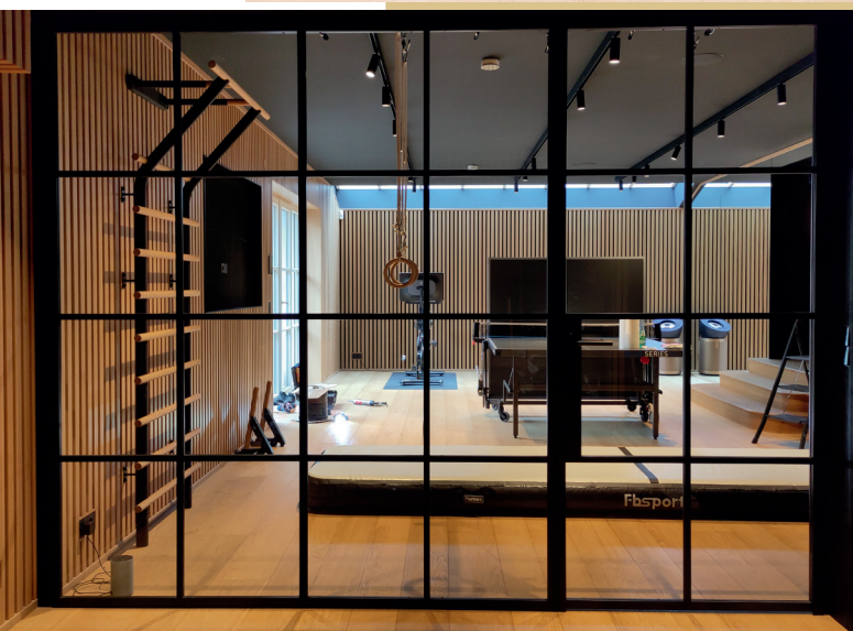
Pulverbeschichteter Raumteiler, eine Kombi- nation aus Fixverglasung und Türelement
