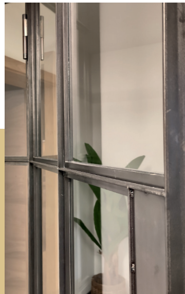
Beim Schwarzstahl bleiben die natürliche Walzoberfläche und die Schweißnähte sichtbar.
